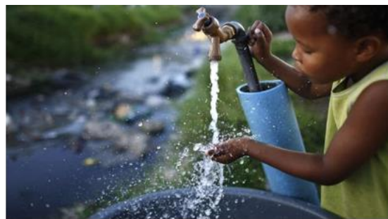
Système de pompage d'eau douce souterraine
